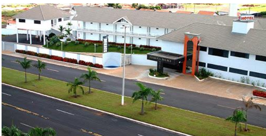
Figuras 249: Fachada do hotel.
