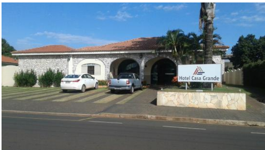
Figuras 250: Fachada do hotel.
