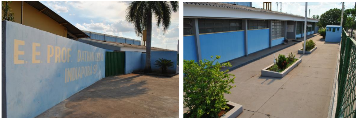
Figura 156-157: Imagens do exterior e interior.
