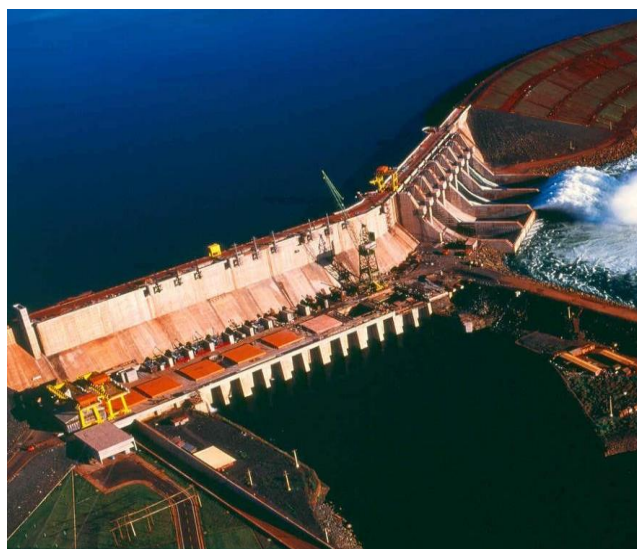
Figura 62:Foto aérea da Usina de Água Vermelha. Fonte PMI Cliente: CESP – Companhia Energética de São Paulo.
