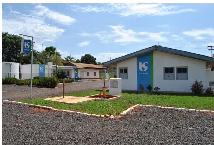
Figuras 179-181: Estação de Tratamento/reservatório.
