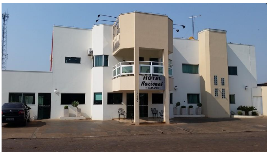
Figuras 251: Fachada do hotel.
