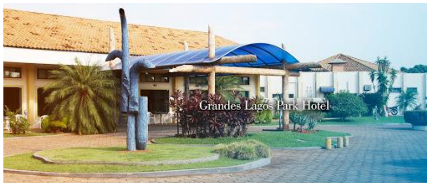
Figuras 246: Fachada do Hotel.
