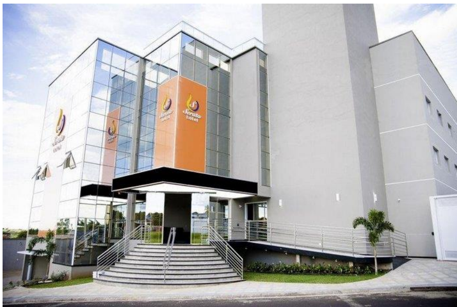
Figuras 244: Visão geral da fachada.
