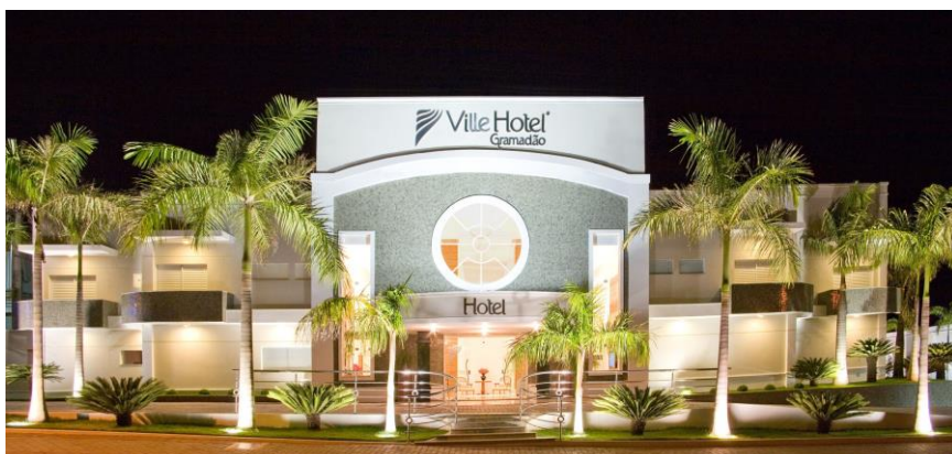
Figuras 248: Fachada do hotel.
